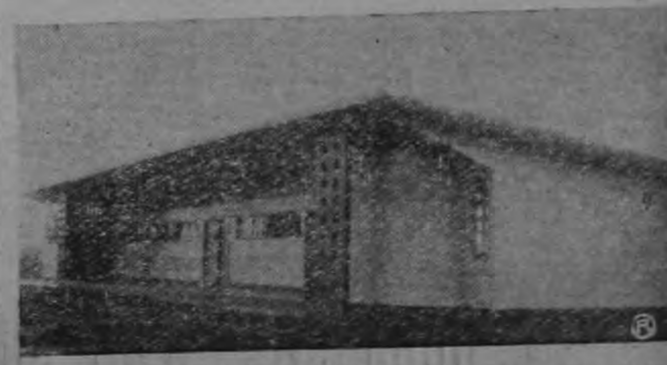
LA HERMOSA ESCUELA DE AGUAS ZARCAS. — He aquí la fachada de la Escuela de Aguas Zarcas, que el domingo quedó inaugurada en una concurrida ceremonia, que se convirtió en un día de fiesta para el vecindario.
